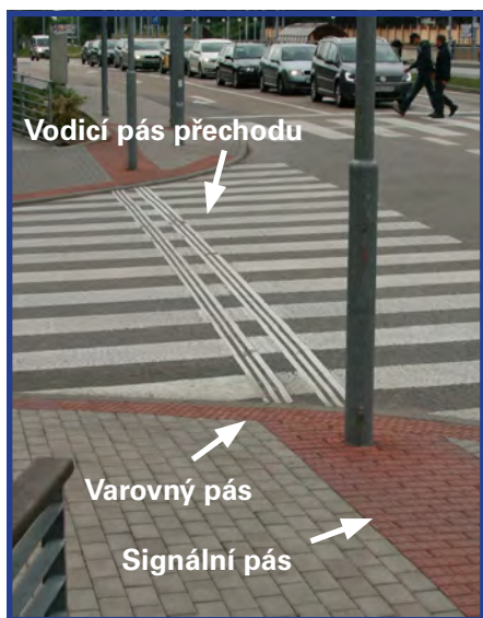
Obrázek č. 10 – Signální pás, vodicí pás přechodu a varovný pás
