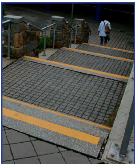
Obrázek č. 25 – Označení hran schodů
