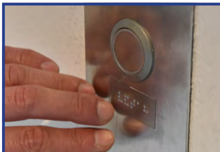
Obrázek č. 16 – Hmatově označená ovládací tlačítka na nástupním místě do výtahu
