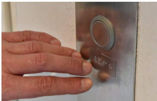
Obrázek č. 36 – Hmatově označená ovládací tlačítka na nástupním místě do výtahu
