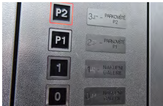
Obrázek č. 35 – Hmatově označená ovládací tlačítka v kabině výtahu
